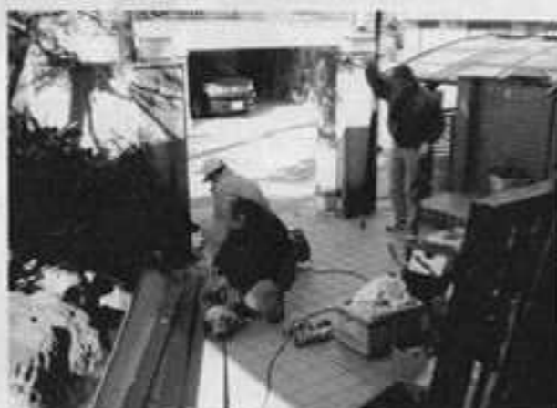
仕事の丁寧さが認められ、本来の仕事ではなかった玄関扉の取替えも頼まれました。
